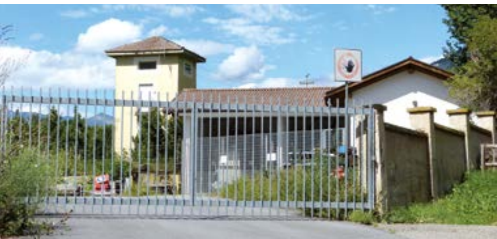
Mit einem Durchfahrtsrecht wurde die Erreichbarkeit der E-Kabine auf der Rückseite der Obstgenossenschaft Geos schriftlich festgelegt.
